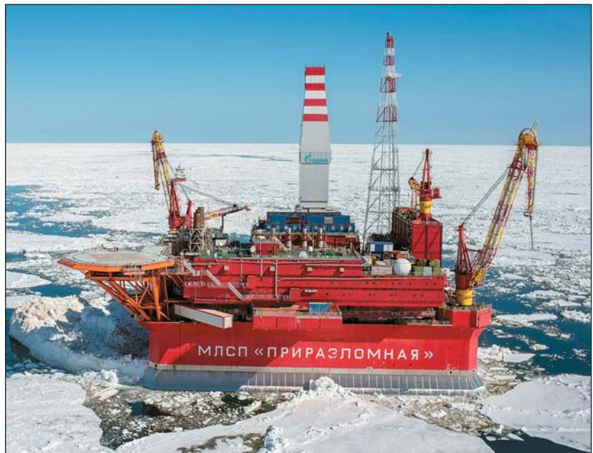
Морская ледостойкая стационарная платформа «Приразломная» (2013), ведущая добычу нефти на российском арктическом шельфе.
